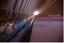
Уникальный способ монтажа деревянных клееных арок укрупненными блоками позволил сократить время строительства.
