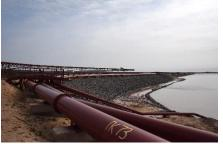
Перевезено и насыпано в тело дамб 700 000 м³ грунта. Уложен экран из полиэтиленовой пленки  $180~000~\text{м}^2$ . Положено технологических шламопроводов и рассолопроводов из новых стальных труб – 9373~м. Заменены самотечные водоводы Ду $1200 \div 1400~\text{мм}$ , Ду $600 \div 700~\text{мм}$ .
