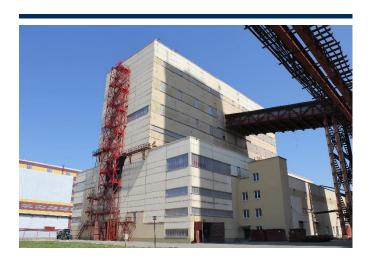
Смонтировано 1500 т металлоконструкций, около 2300 м<sup>3</sup> монолитных бетонных и железобетонных конструкций, около 3500 м<sup>2</sup> кровельных работ, 2515 м<sup>2</sup> стенового ограждения из нержавеющей стали, проложено 27 тыс. м кабеля.
