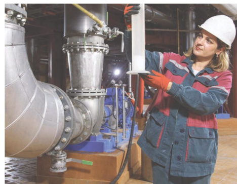
Мастер Ю.Ф.Мелешко измеряет плотность хлоркалевой суспензии.
