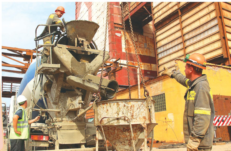
Прием бетономеси для устройства монолитного перекрытия.
