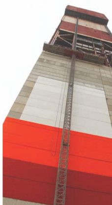
Северная сторона башенного копра №4. Защита и покраска стеновых панелей.
